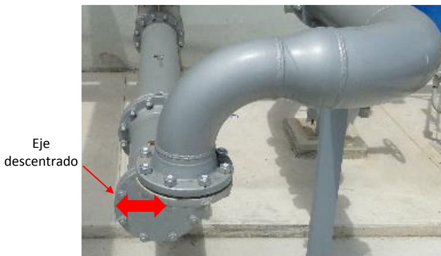
FOTO 6: MODIFICACIONES EN LA DESCARGA DE LA 3P-3226 C
