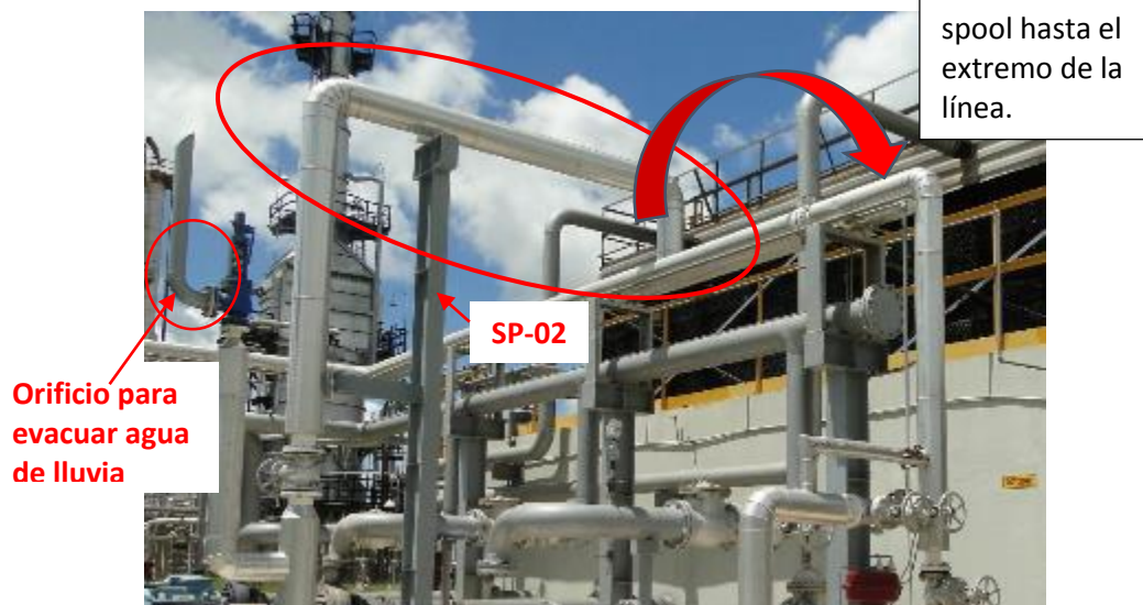
FOTO 3: MODIFICACIÓN LÍNEA DE SALIDA DE LA TURBINA
