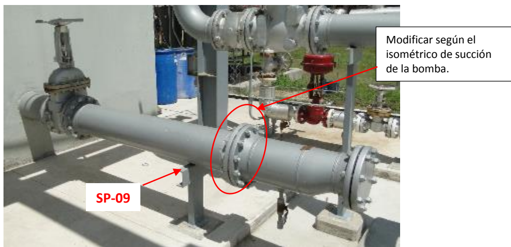
Foto 5: MODIFICACIONES LINEA DE SUCCION DE AGUA
